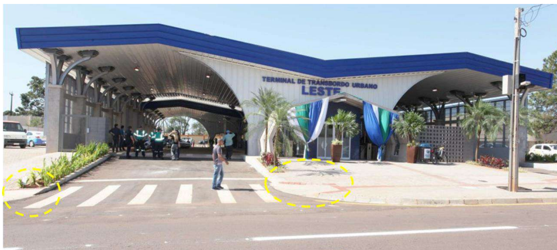
Figura 281: Rampas de acesso ao Terminal Leste
