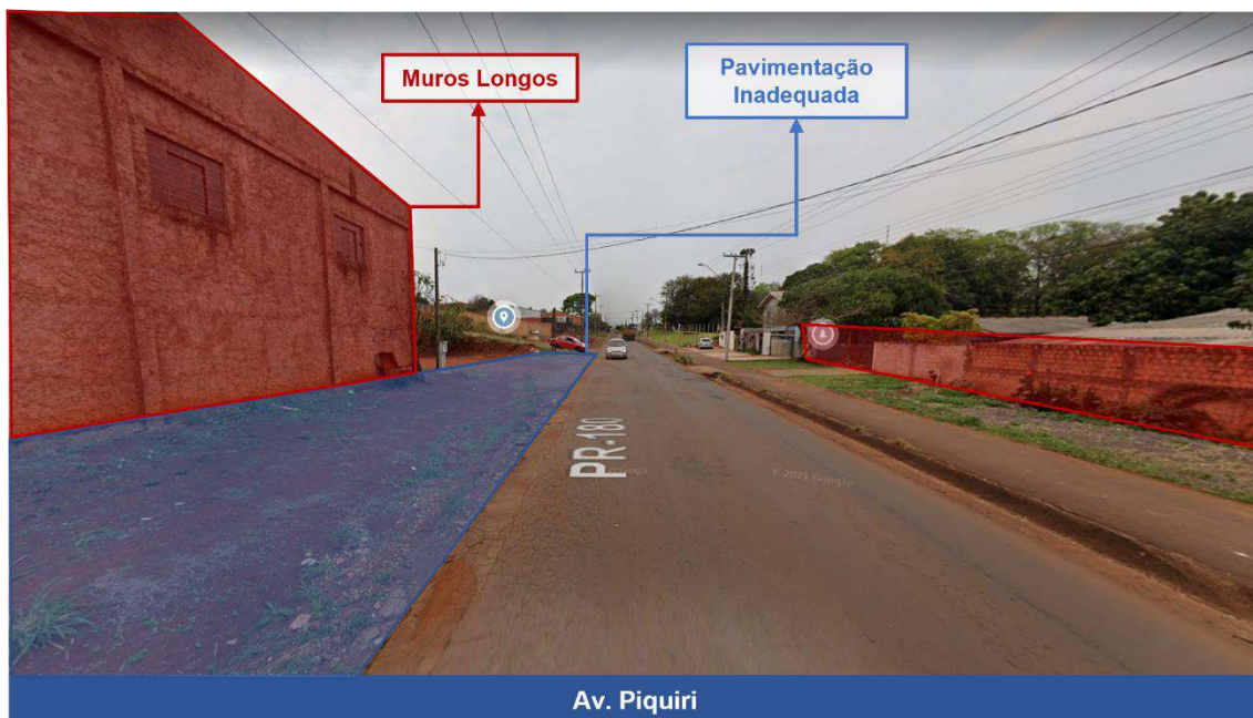
Figura 231: Aspectos da Calçada – Av. Piquiri
