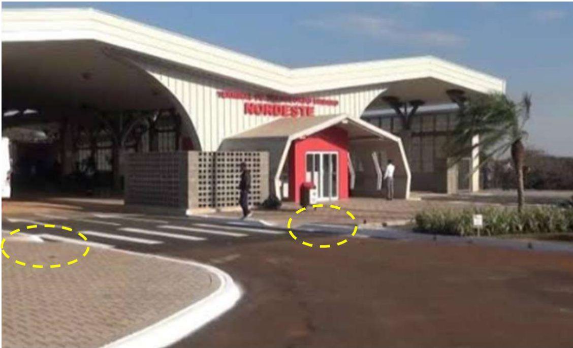
Figura 284: Rampas de acesso ao Terminal Nordeste
