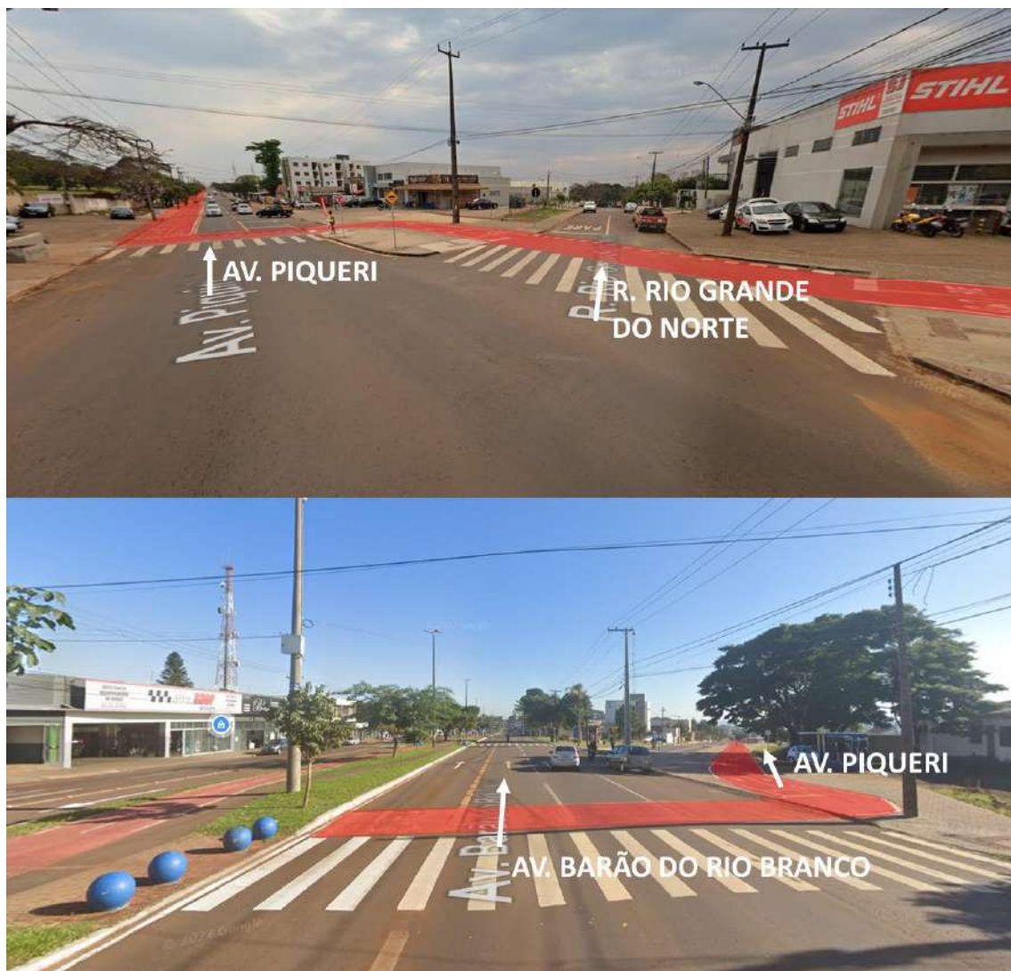
Figura 245: Exemplos de travessias existentes
