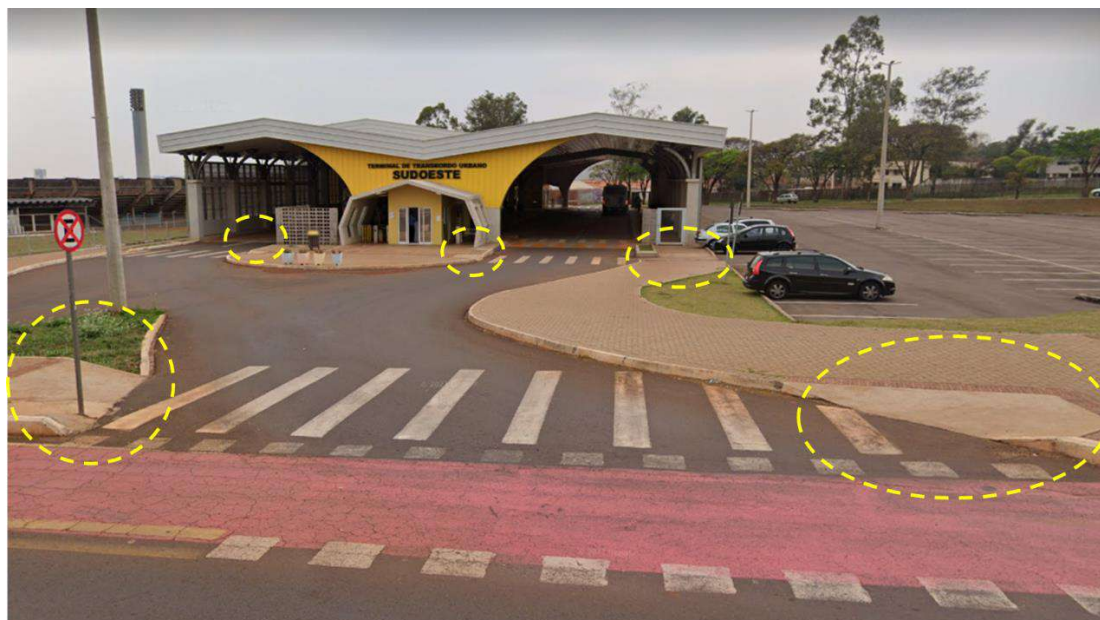
Figura 271: Rampas de acesso ao Terminal Sudoeste
