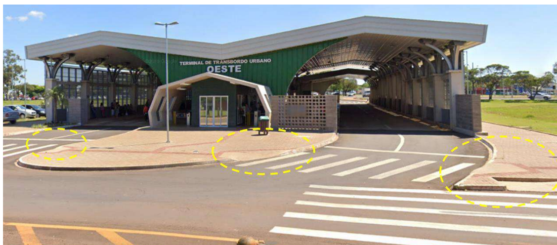
Figura 274: Rampas de acesso ao Terminal Oeste
